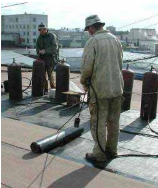
Рис. 32. Положение рабочего при укладке.
