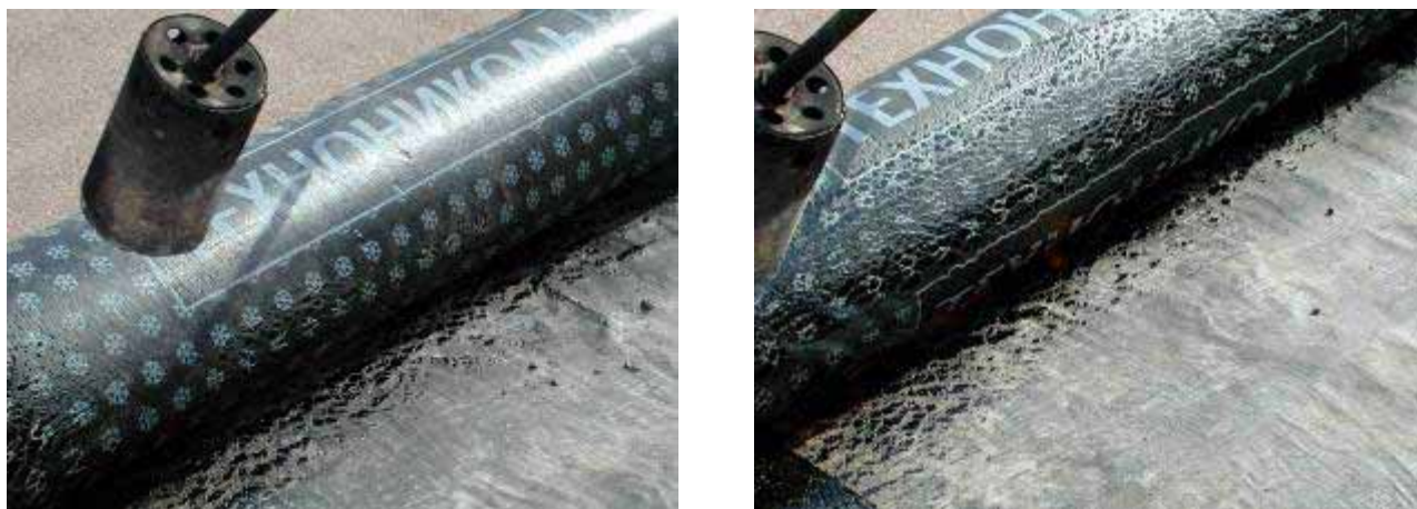
Рис.33. Пропадание рисунка на нижней стороне материала при правильном разогреве.
