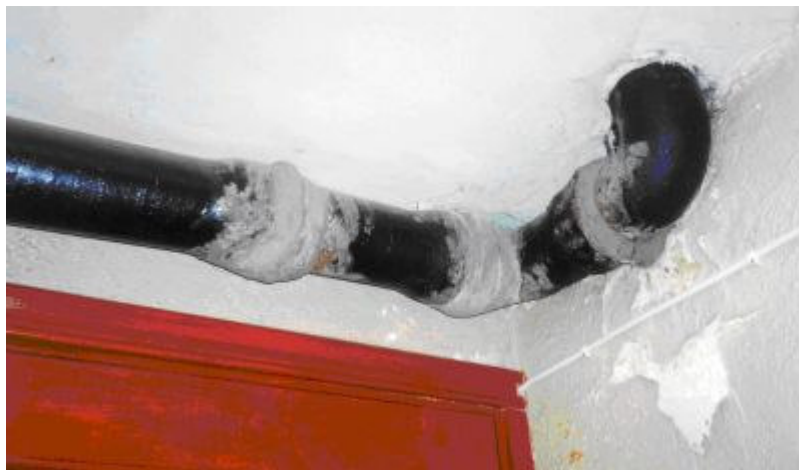
Foto kaks järjestikku torupõlve on põhjustanud läbijookse nii ummistumise kui ka ebatiheduse tõttu.
