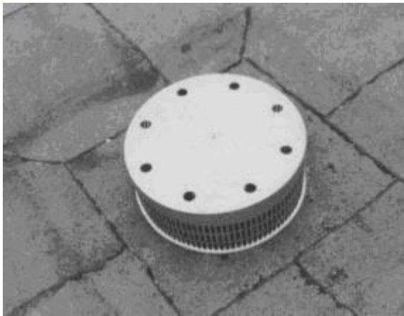
Foto Lisaks tavalisele prahisõelale on äravool varustatud suurema lehesõelaga.
