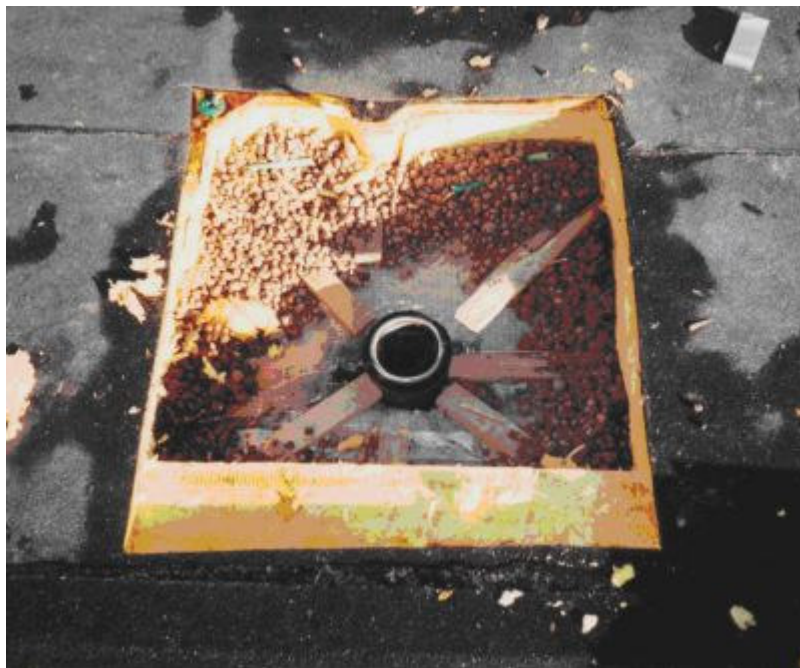
Foto Avatud äravoolukaev – põhjuseks aurutõkke ebatihedus ja vähese töökindlusega probleemialdis katuselahendus.
