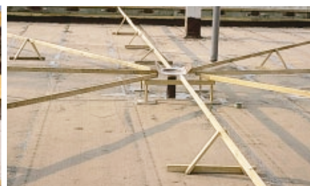
Korkolinjat asennetaan kevytsoran yläpinnan tasoon.
