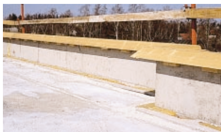
Räystäsrakenteet tehdään valmiiksi ennen kevytsoran levitystä.
