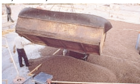
Kevytsora nostetaan katolle nostolaatikoilla ja tasataan oikeaan korkeuteen.
