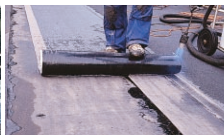
Bitumikermi asennetaan pintabetonilaatan tai katelaattojen päälle.
