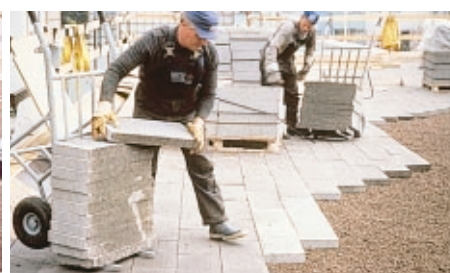
Kevytsoran päälle ladotaan kevytsorabetoniset katelaatat.
