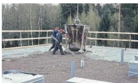
Katelaattojen sijasta voidaan valaa paikalla ohut, 30 - 40 mm pintabetonilaatta.
