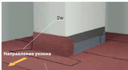
Покрытие ската подкладочным рулонным кровельным материалом
